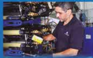
Serviços de Manutenção
