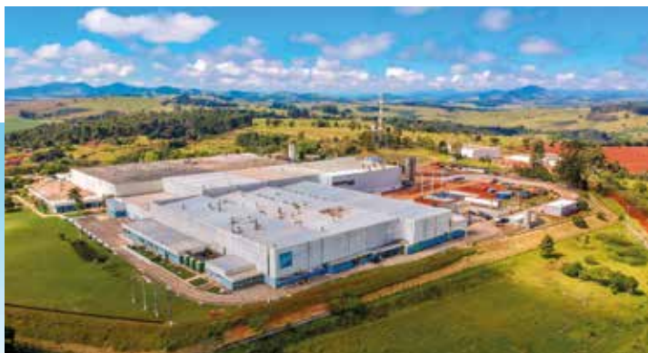
Primeira fábrica de latas de alumínio para bebidas da América Latina, localizada no município de Pouso Alegre (MG)
