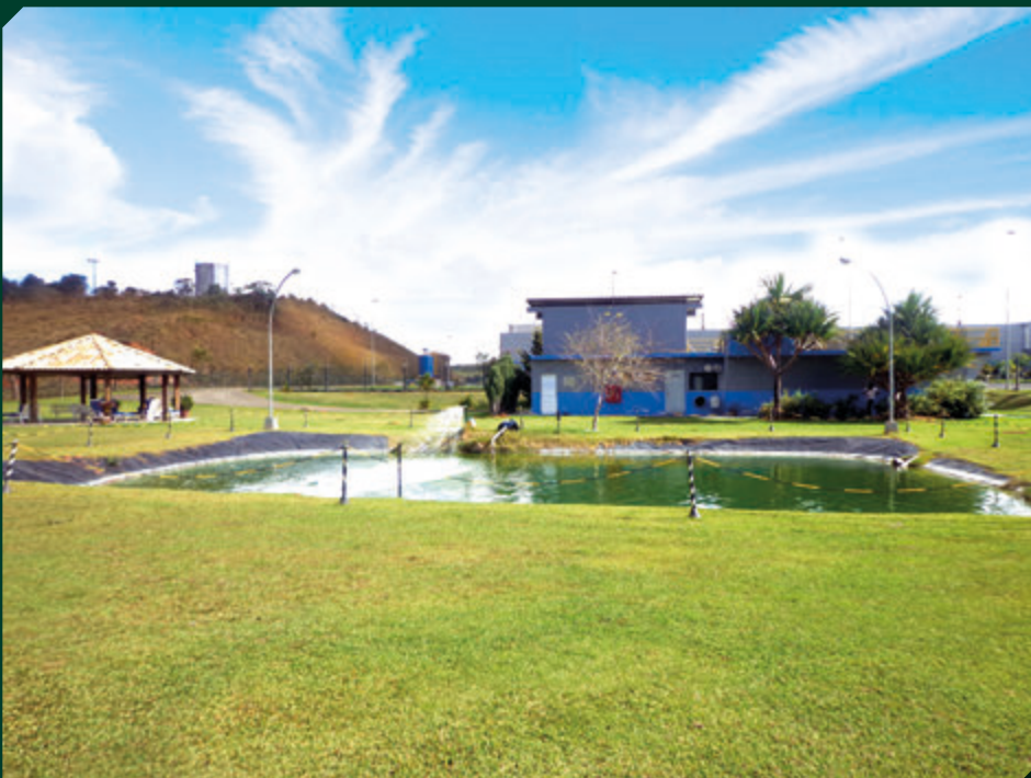
Estação de tratamento de efluentes da Rexam
